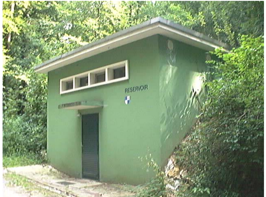
Abb. 17: Das Ettinger Reservoir bestehend aus zwei Kammern zu je 256 m 3 und 310 m 3
